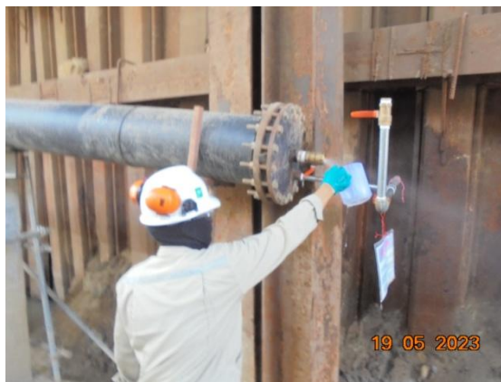
บริเวณจุดปล่อยน้ำทิ้งจากการทดสอบท่อด้วยวิธีทางชลสถิตย์
